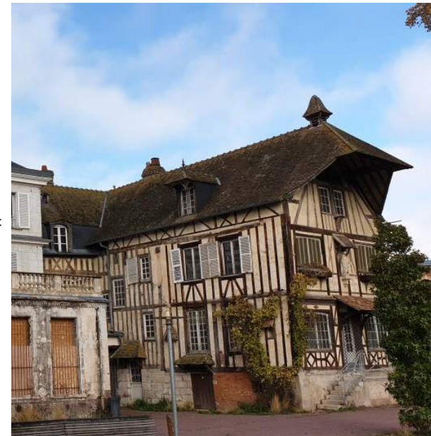
Pignon sur parc
