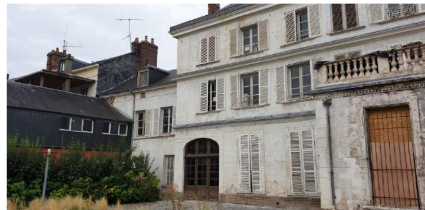
Façade côté parc : lien avec les bâtiments A3 et A4
