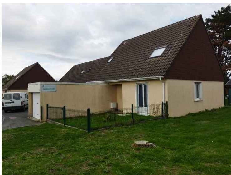
Travaux de remplacement des gouttières Les Anémones à Conteville
