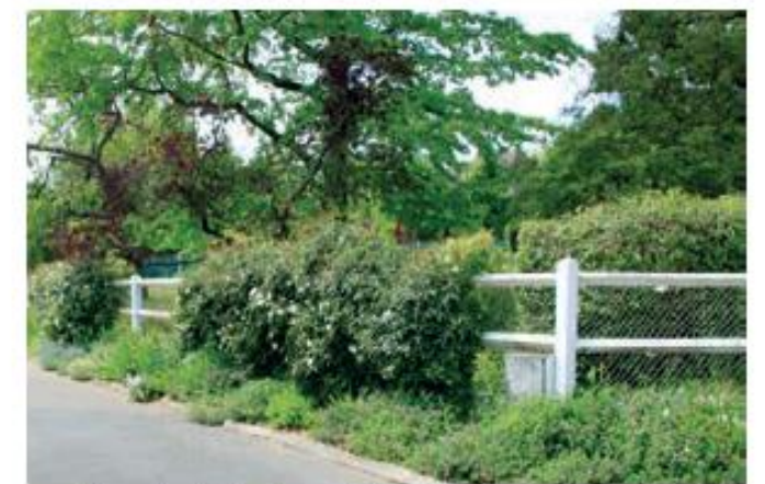
Lisse doublée d'un grillage simple torsion galvanisé.
